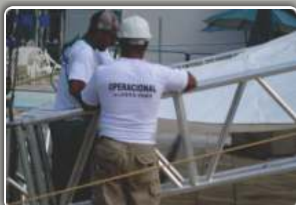
Equipe de montagem e desmontagem
