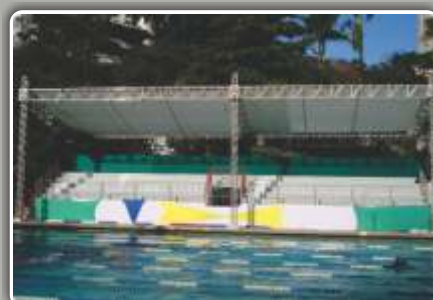
Arquibancadas com cobertura
